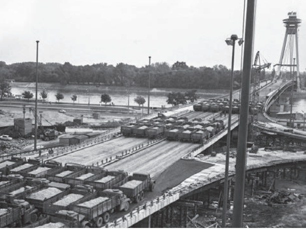
Zatažkávací skúška Mosta SNP
